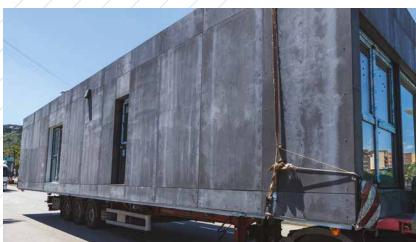
Module assemblé en usine
