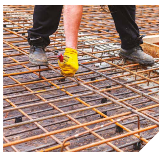
Préfabrication d'une prédalle béton, posée sur chantier
