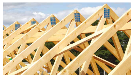
Charpente bois préfabriquée
