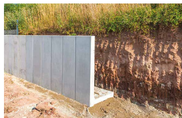
Mur de soutènement
