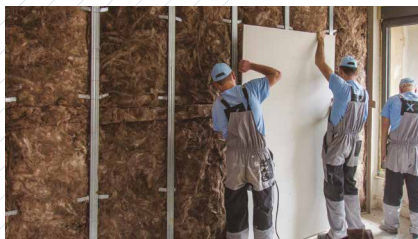
Pose de plaques de plâtre
