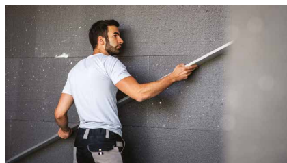
Pose d'une solution d'isolation « collée » sur un mur porteur
